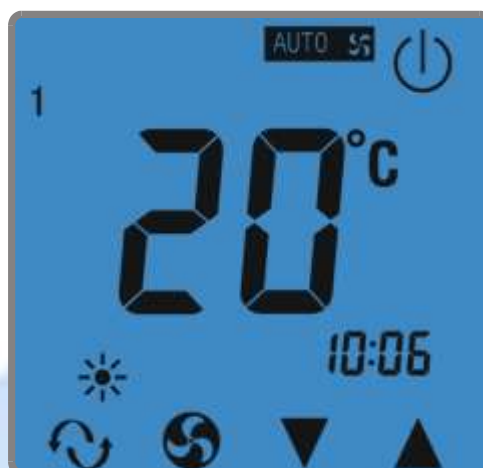
Ekran 5. Aktywacja nagrzewnicy kanałowej
